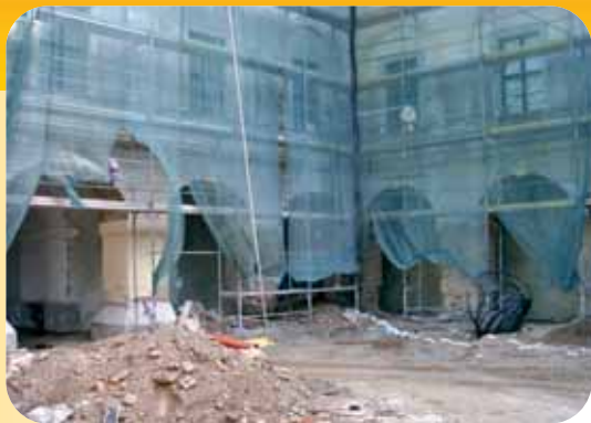
Schloss Hof während der Sanierung
