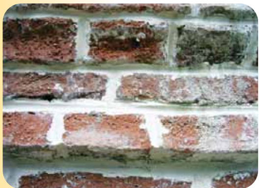
Verfugung mit KALKopor
